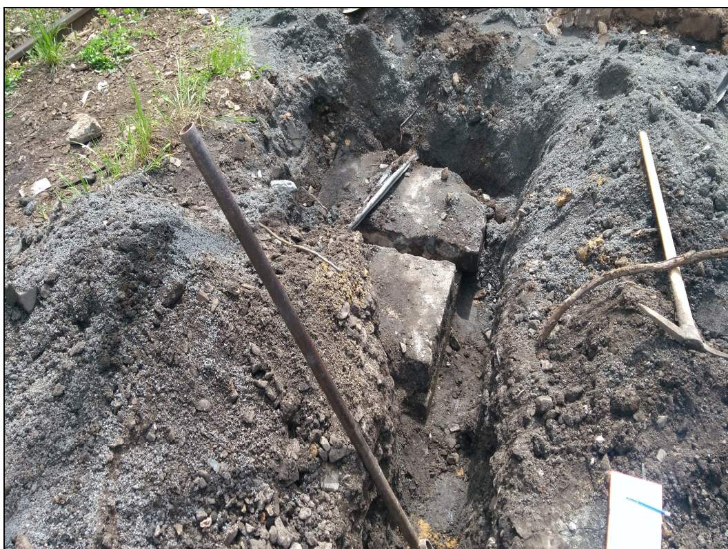
Obr. č. 3 – odkrytá vtoková šachta do propustku kopanou sondou KS02
