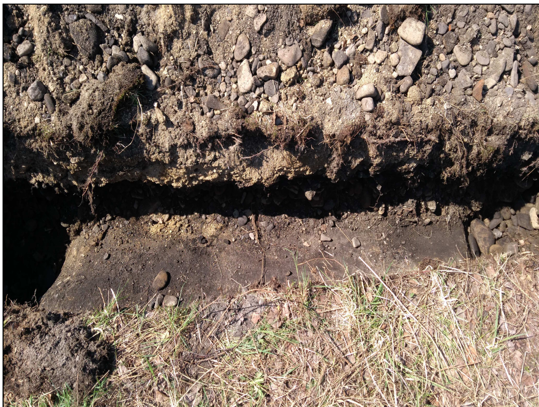
Obr. č. 2 - odkrytý propustek kopanou sondou KS01
