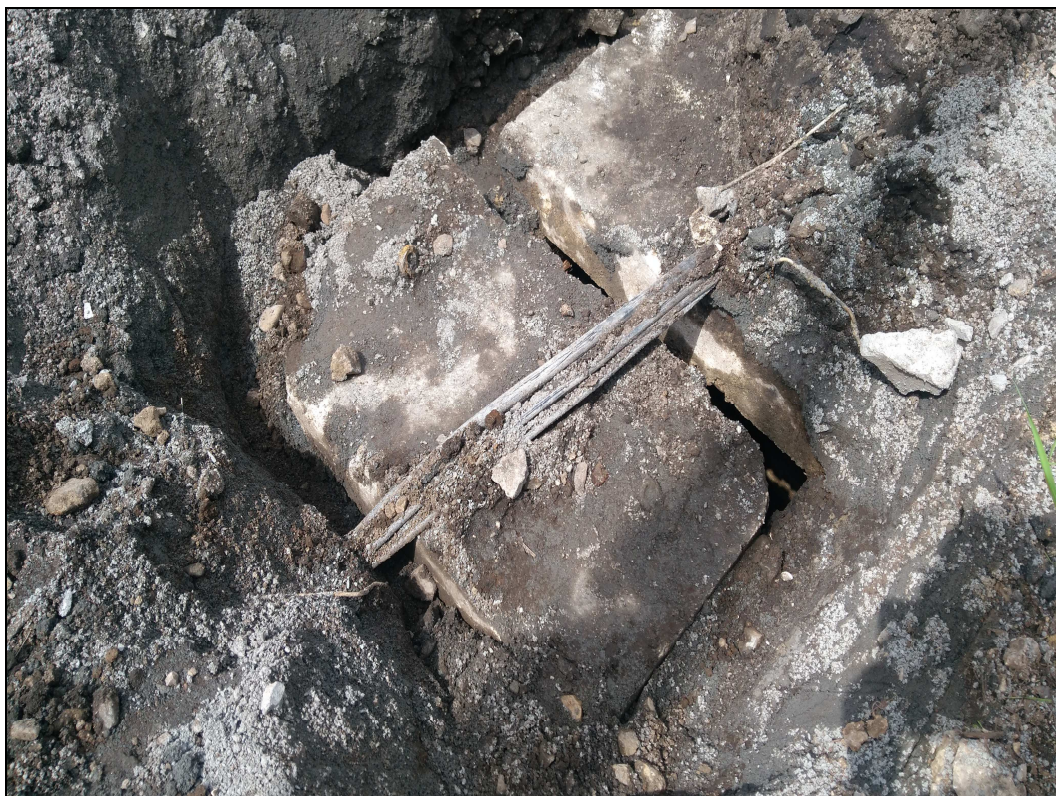
Obr. č. 4 – odkrytá vtoková šachta do propustku kopanou sondou KS02
